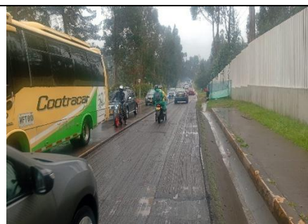
Foto Avance (K12 + 998 IZQ y 06/01/2026)
