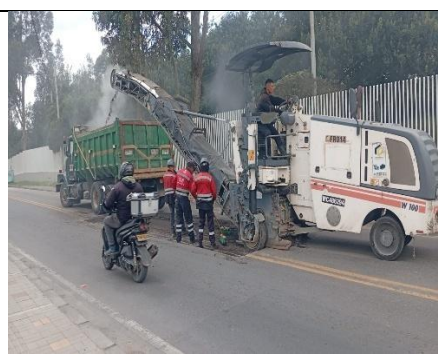
Foto Avance (K13 + 033 IZQ y 06/01/2026)
