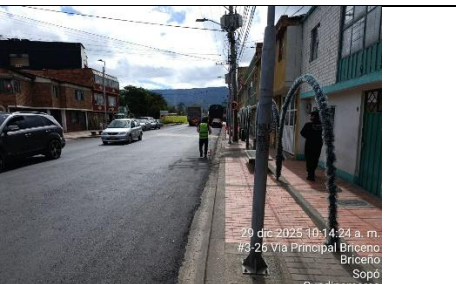
Foto Avance (K14 + 182, 29/12/2025)
