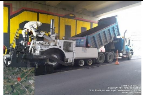
Foto Avance (K14 + 11.80 DER y 23/12/2025)
