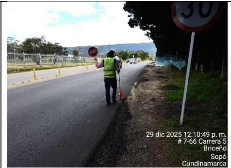
Foto Avance (K13 + 800, 29/12/2025)
