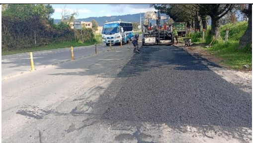
Foto Avance (K13 + 920 IZQ y 26/12/2025)
