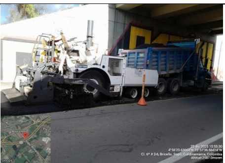
Foto Avance (K14 + 026.60 DER y 23/12/2025)
